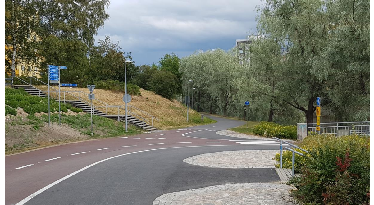
Pyöräliikenteen pääreitillä sivusuunnat väistävät ja reitit ovat viitoitettuja (valokuva Reijo Vaarala).
